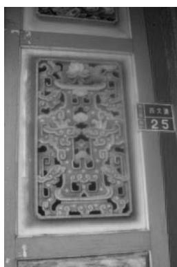
位於西文里 25 號「文澳城隍廟」三川殿門板螭虎圍爐造型的木雕，為保留精緻的建築特色
